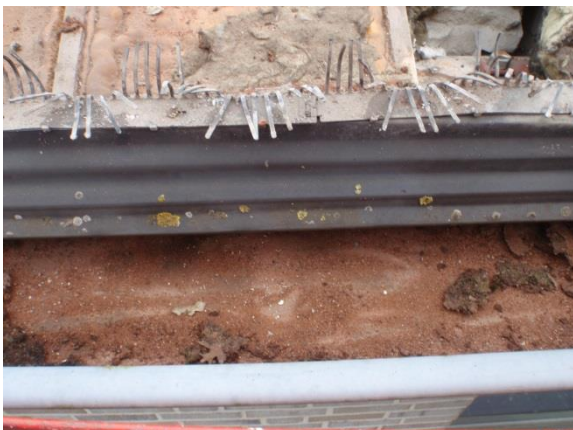
Foto 17 De conditie van de zinken goten is redelijk.
