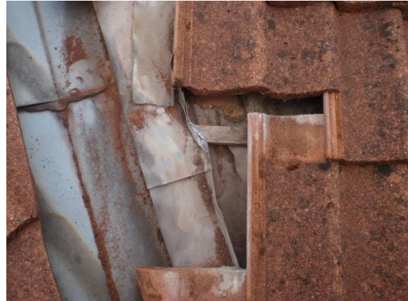
Foto 14 Kilgoot, de conditie is redelijk.
