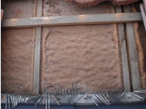
Foto 7 Het isolatiemateriaal is onafgeschermd maar droog.
