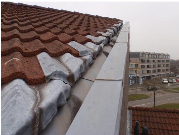
Foto 15 Dakrand, de dakpannen zijn ingedekt met lood.
