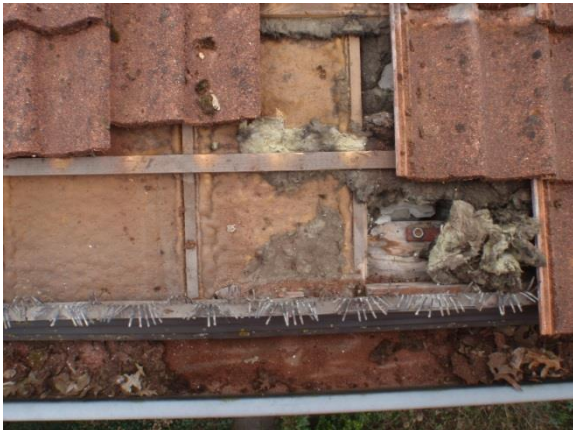
Foto 3 Destructief onderzoek, de constructie is droog.
